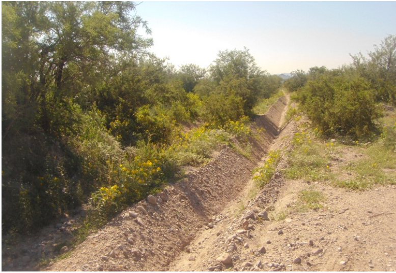
Figura 26.- Derivación de escorrentía superficial de un cauce natural mediante un bordo de contención.
