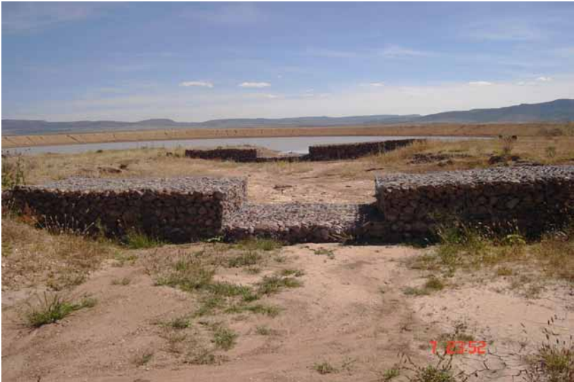
Figura 27.- Presa filtrante de piedra sobre arroyo efímero.
