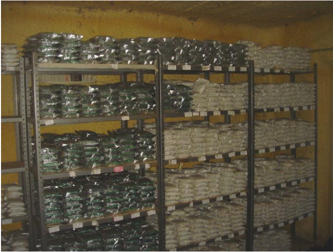
Figura 7. Cámara de colecciones base, donde las accesiones se encuentran entre -18 y -20°C y 10-15% de humedad relativa.
